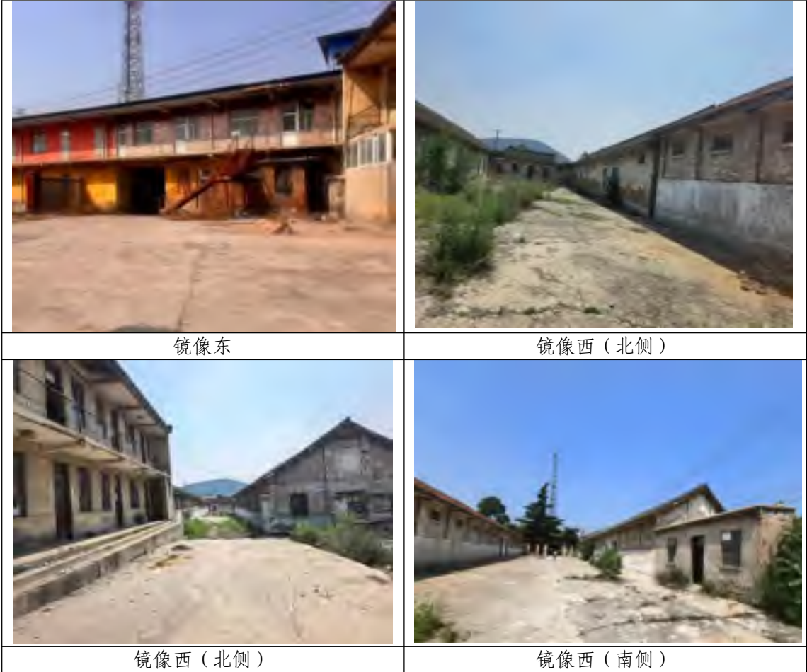
图 1-10 现场情况（时间：2026.5）
