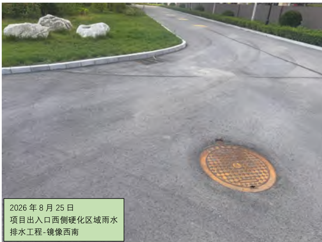
雨水排水工程-1
