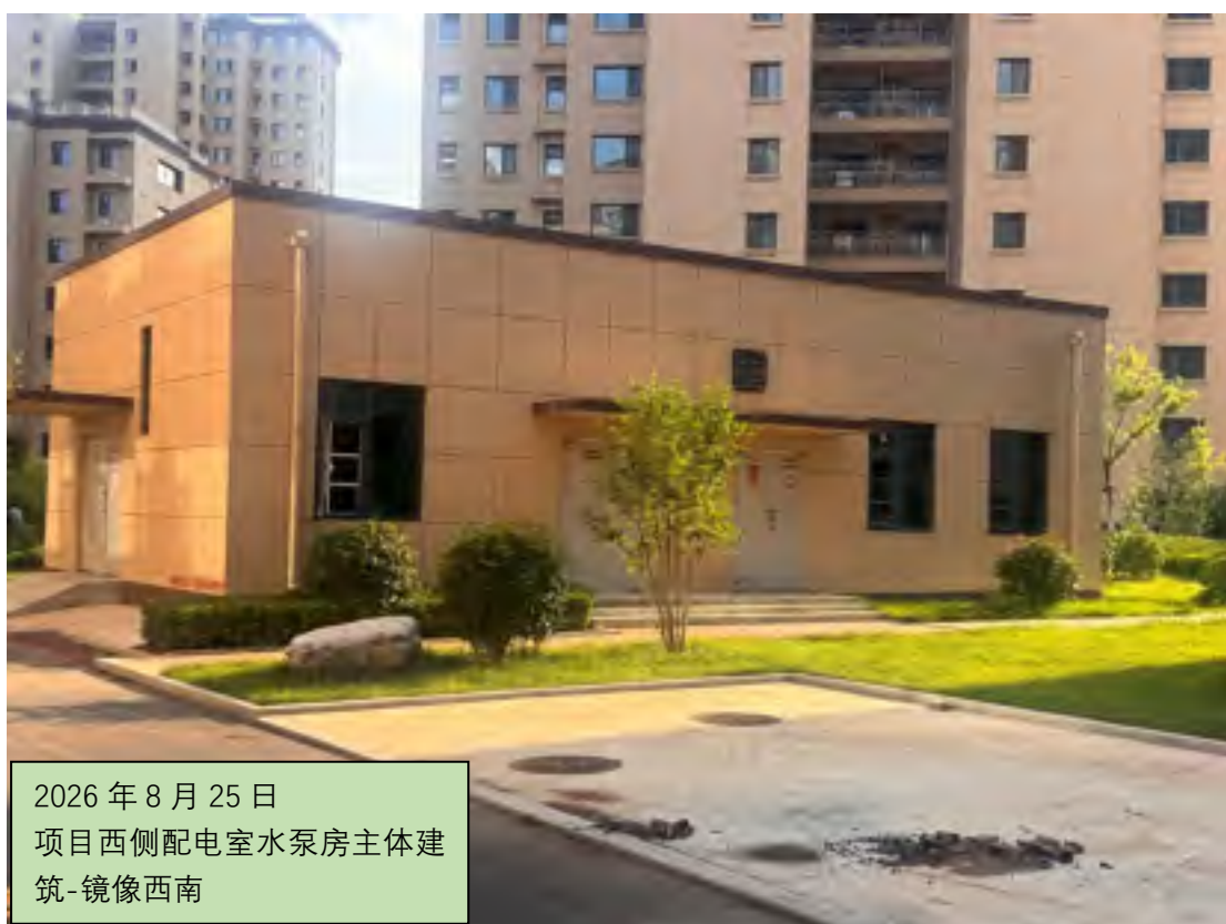
配电室水泵房主体建筑现状照片
