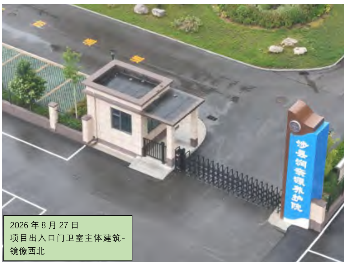
门卫室现状照片
