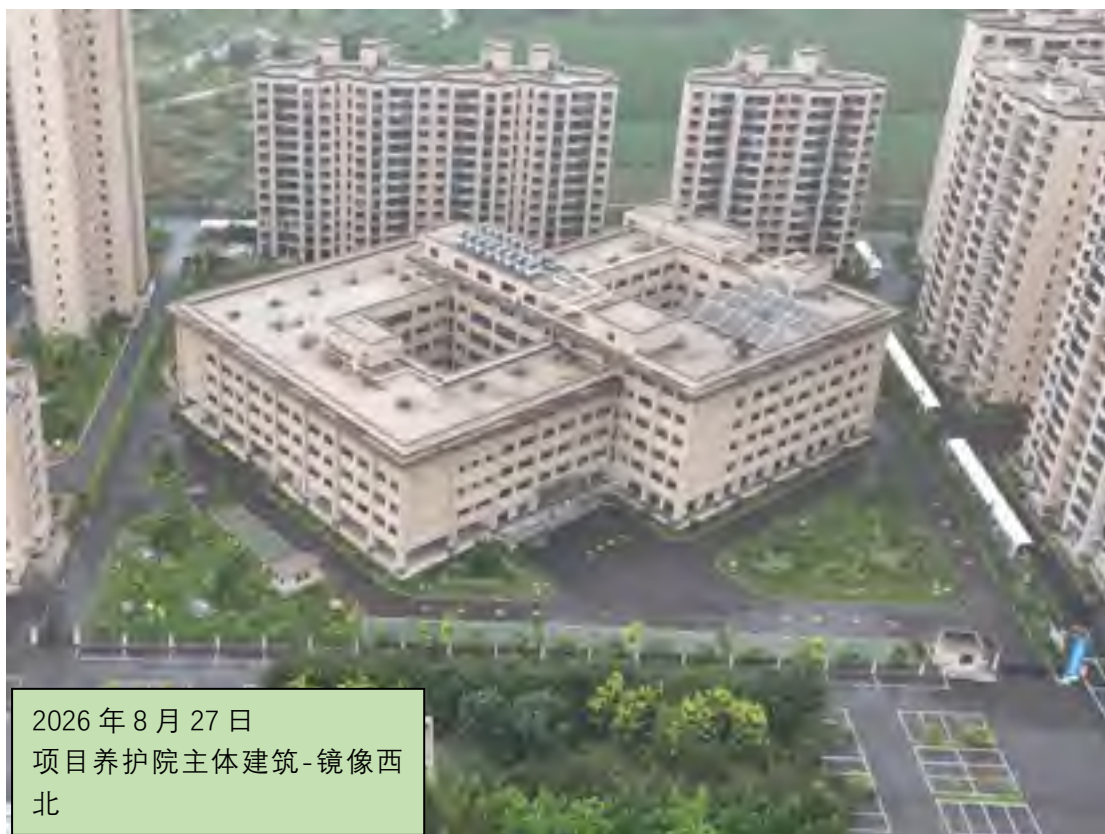
养护院主体建筑现状照片
