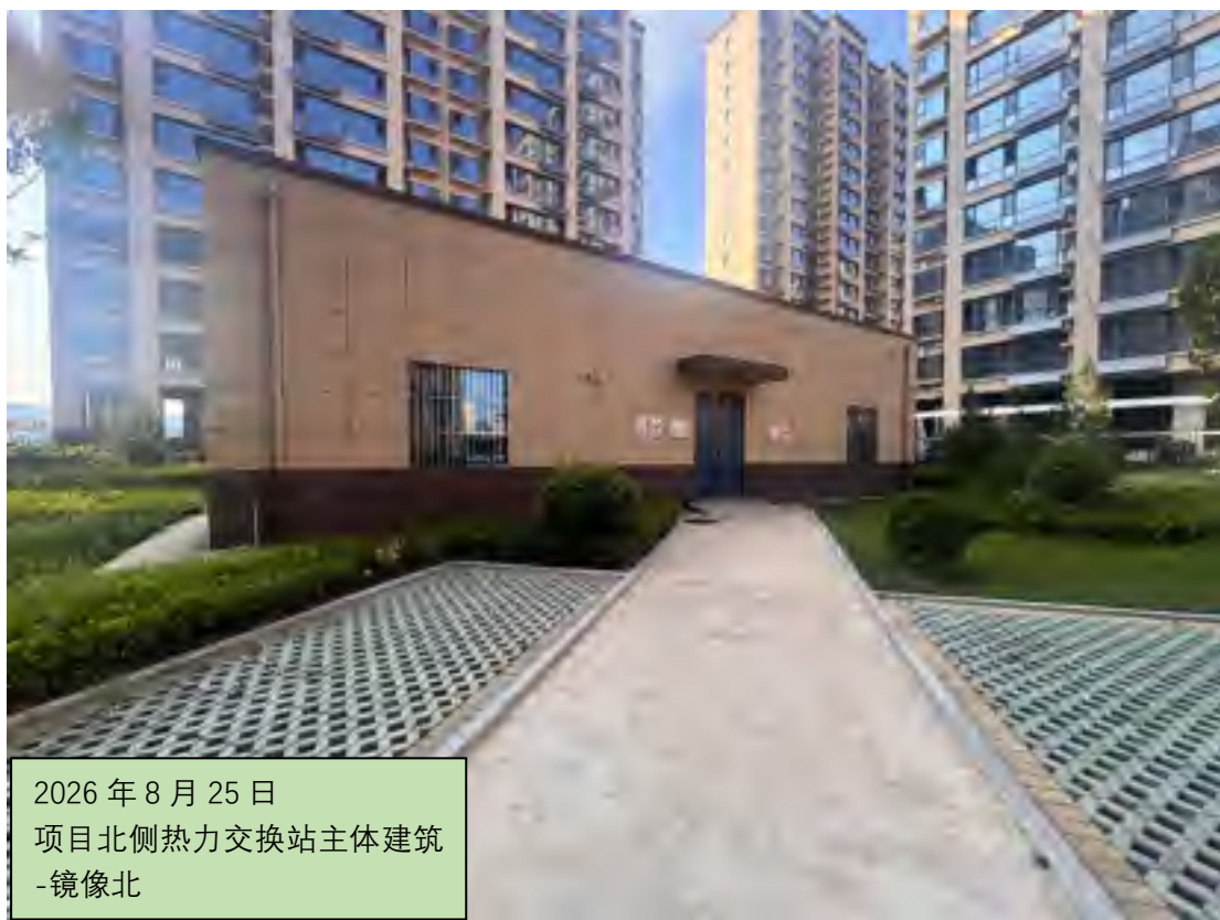
热力交换站主体建筑现状照片
