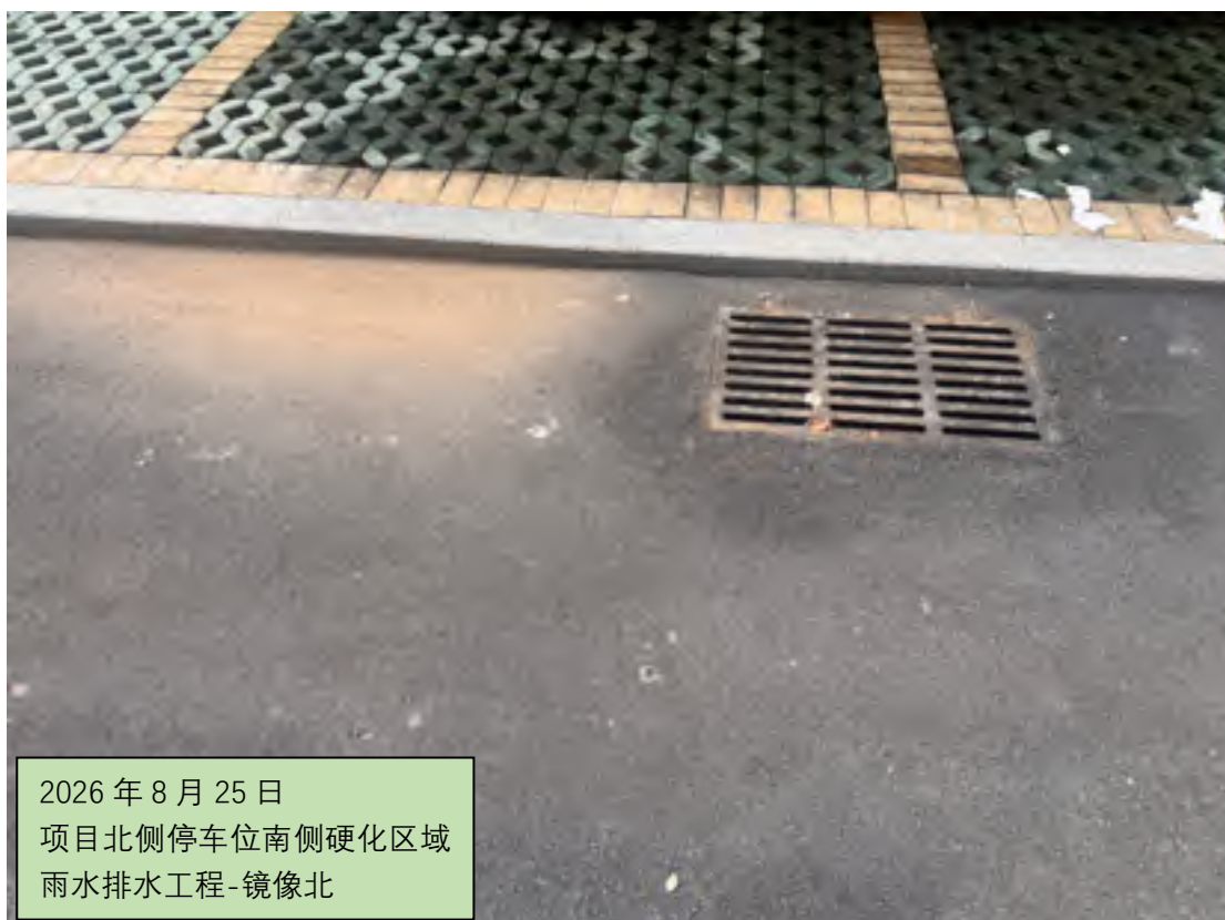
雨水排水工程-2
