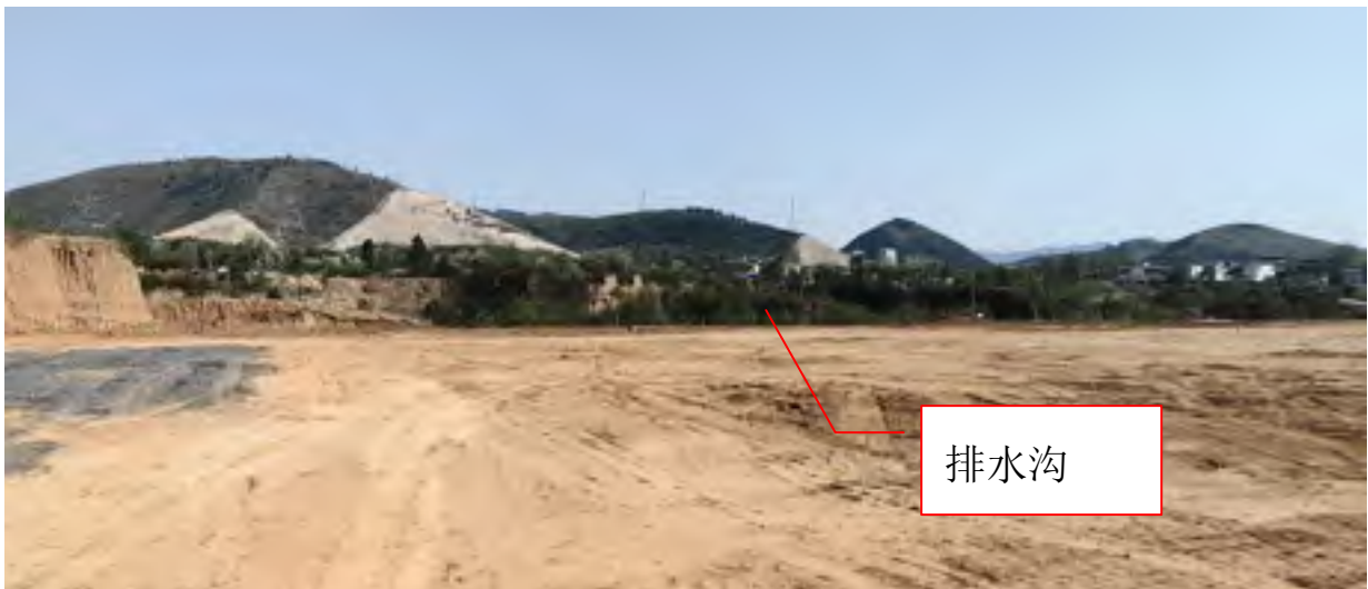
照片 1-4 场区现状（镜向东）
