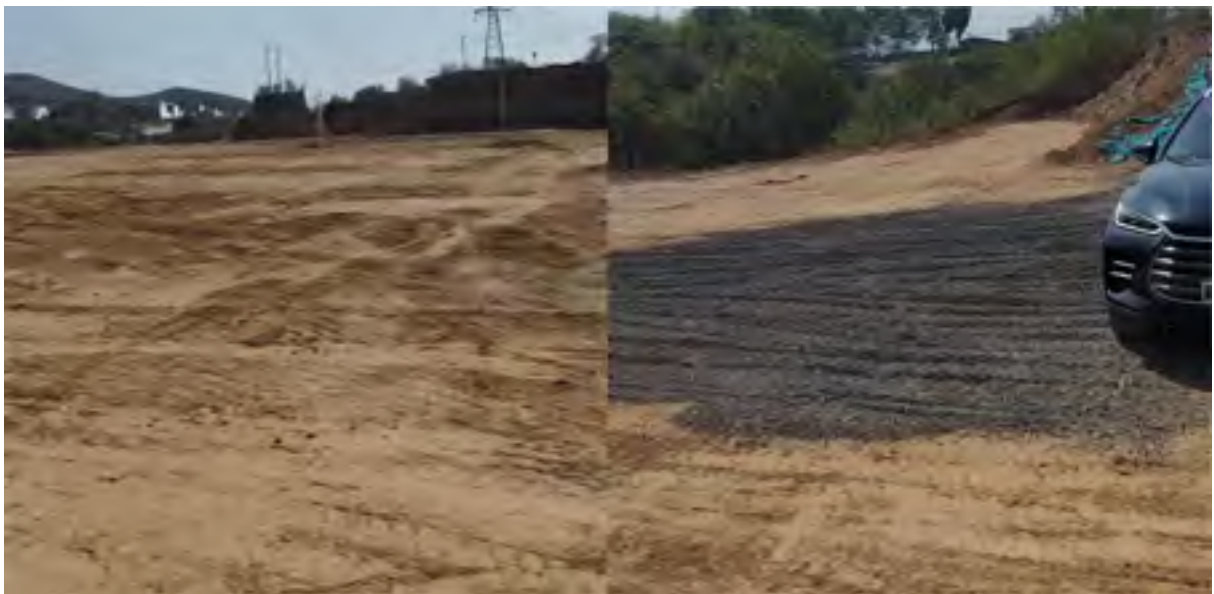
照片 1-1 项目场区现状
