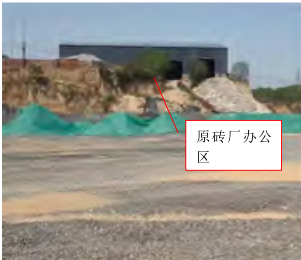
照片 1-3 场区现状（镜向北）
